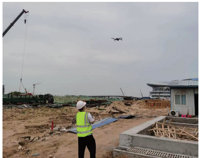
无人机巡查施工现场
